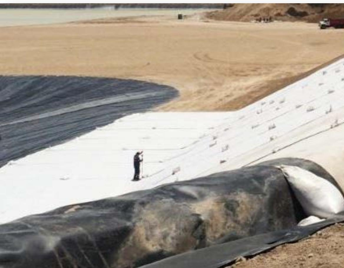
Завершающим этапом при производстве работ по укладке геомембраны является устройство защитного слоя. Данный слой должен выполняться из геотекстиля или сыпучих материалов, либо в их совокупности.
