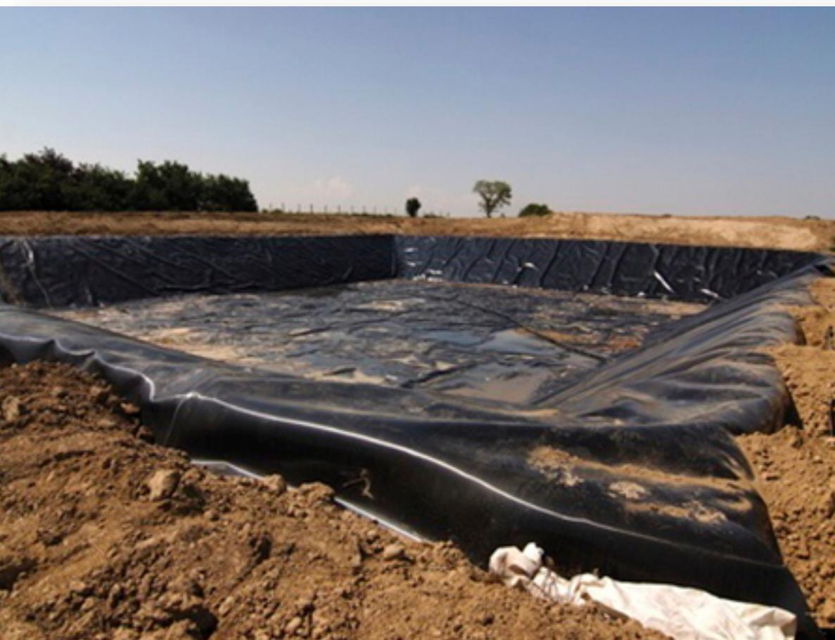
14. Перед наполнением котлована до проектных значений, рекомендуется выполнить наполнение на 10-20%, предварительно ослабив временное крепление геомембраны в анкерной траншее, для равномерного распределения геомембраны под нагрузкой на днище и примыканиях откосов. После этого можно окончательно крепить геомембрану в анкерной траншее.
