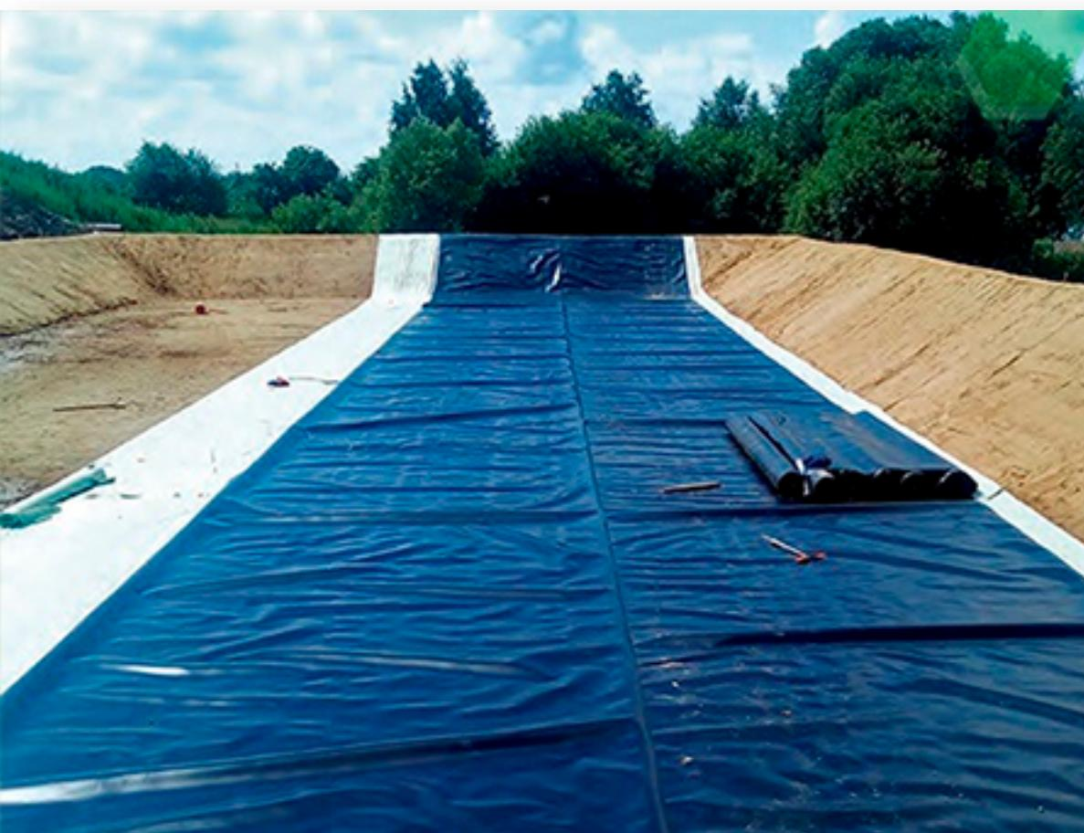
1. Не допускается распаковывать и разворачивать рулоны геомембраны при температуре ниже 0 °C. Обычно должно быть развернуто только то количество полотнищ, которые могут быть закреплены и сварены друг с другом в течение рабочего дня.
